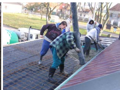
Betonování ploché střechy přístavby
