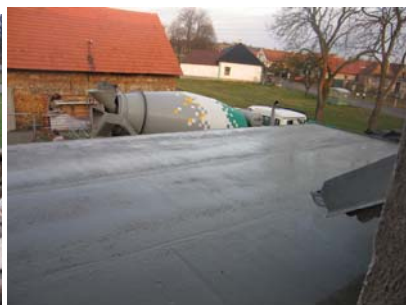
Betonování ploché střechy přístavby
